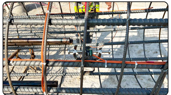
[파일 재하시험용 케이스에 1240 설치 사진]
